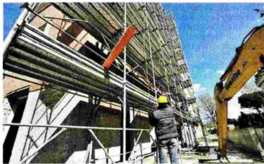
Un cantiere per la costruzione di nuove abitazioni
