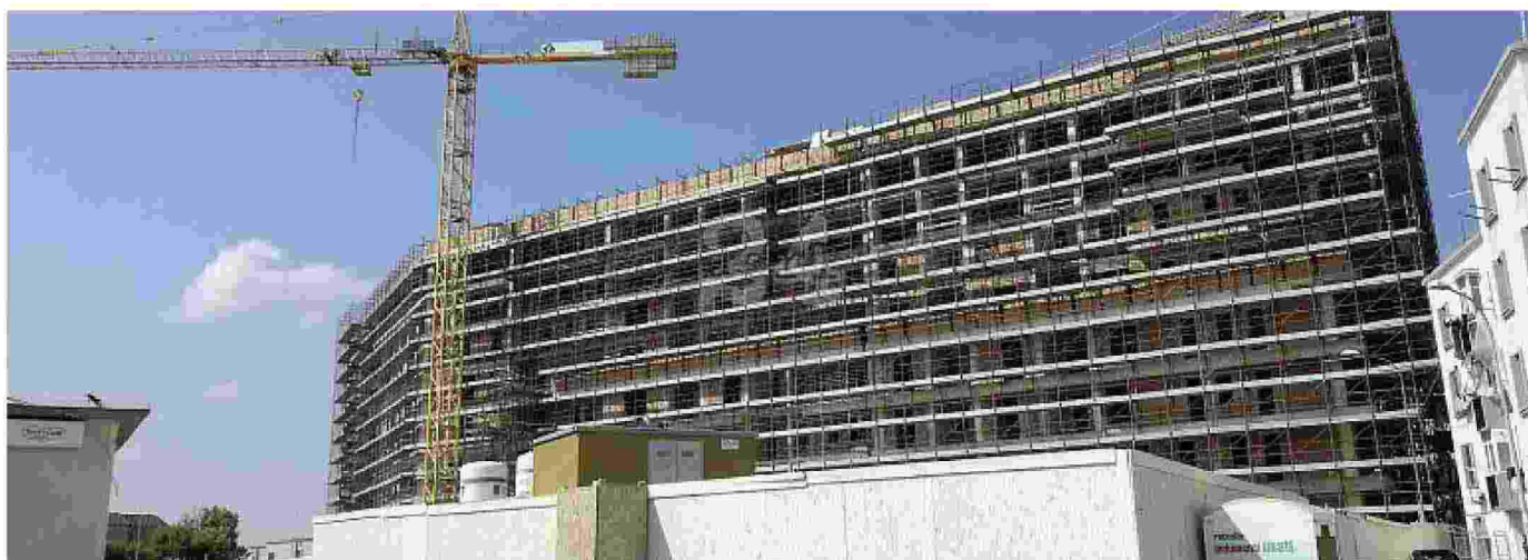
Lavori in corso Una gru e le impalcature operative in un palazzo di nuova costruzione al quartiere San Girolamo, sul litorale nord di Bari
